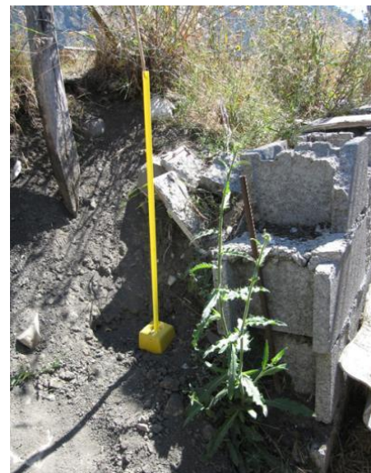
La borne du talus rétablie.
